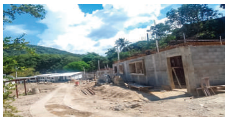
Construcción del complejo habitacional
