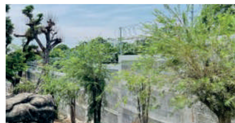
Edificio de Verificación Inmediata Aduana San Cristóbal.
